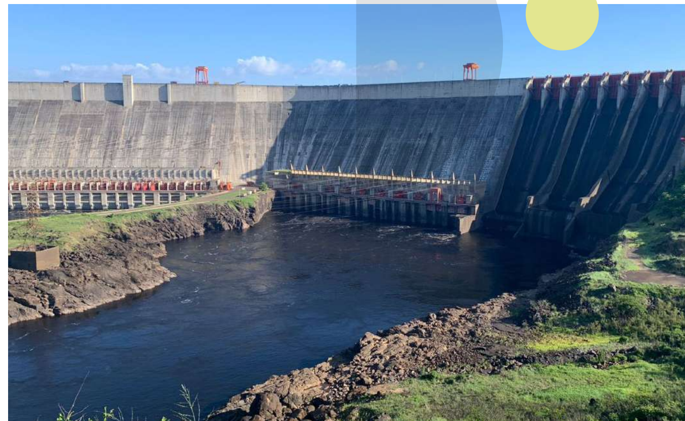
Central Hidroeléctrica Simón Bolívar, Estado Bolívar, Venezuela.
